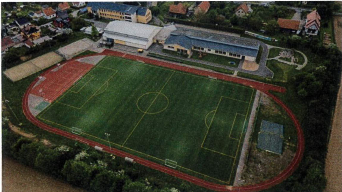
Bild 1: gesamtes Sportzentrum mit Flutlichtanlage
