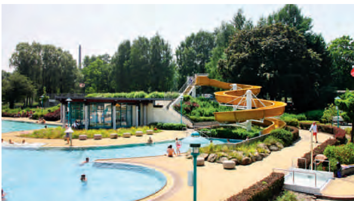
Das Freibad Bischofswerda, geöffnet von Juni bis August täglich von 9 bis 20 Uhr. Für ganz Sportliche: das Schwimmerbecken ist mit sechs 25-Meter-Bahnen ausgestattet
